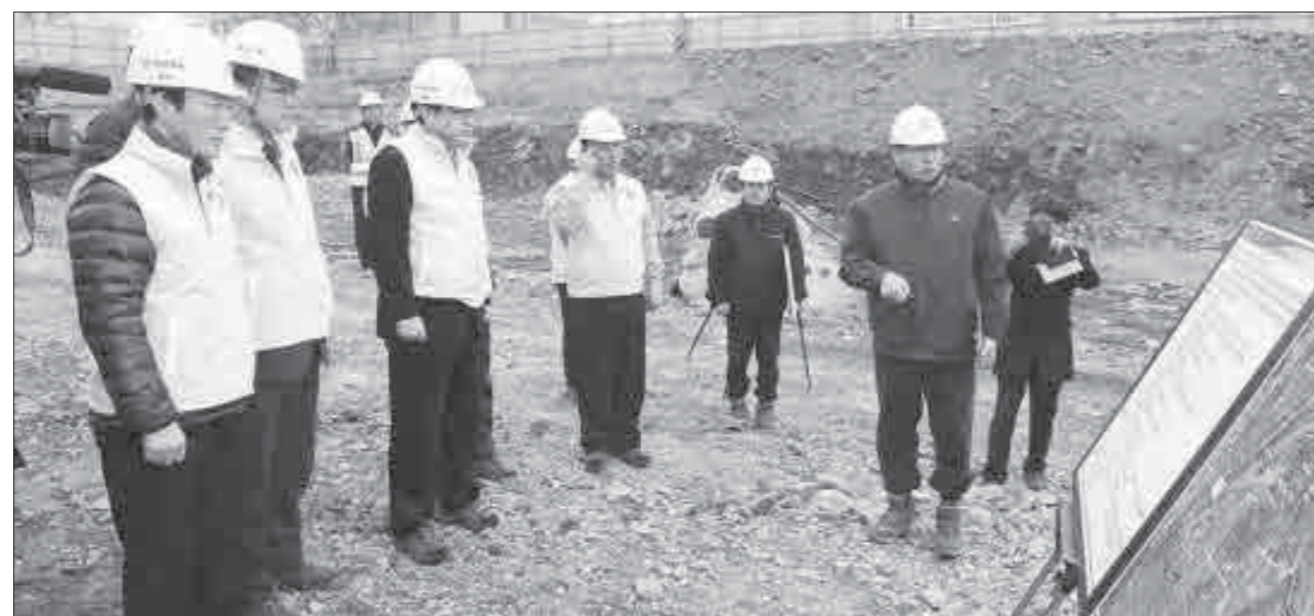
영천시는 지난 24일 영천 완산지구 우수저류시설 설치공사 현장과 이마트 영천점에 대해 현장 안전점검을 실시했다.
